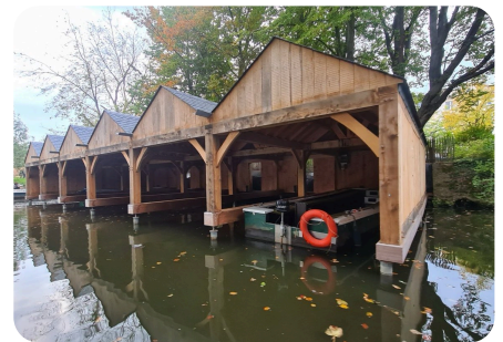
Hangar à bateaux sur la Nèthe
